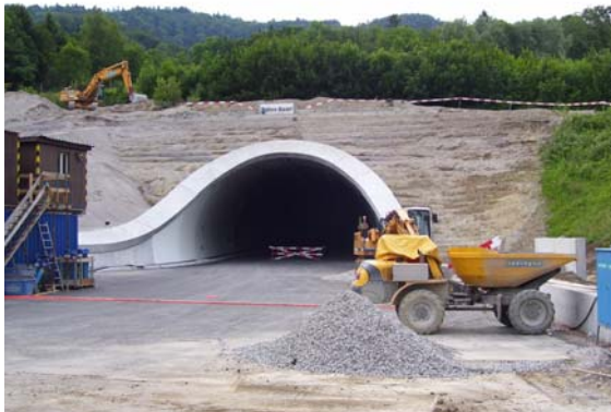
Baustelle der Westumfahrung Zürich
