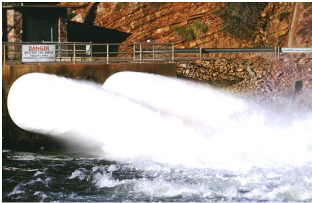
Bild 1: Freistrahler am Grundablass des Argyle-Damm, Australien.
