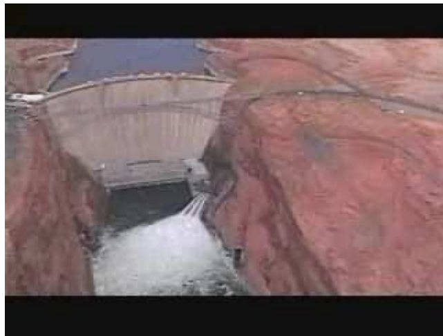
Grundablass einer Talsperre
