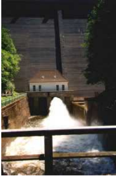
Grundablass der Ekerttalsperre, Harz
